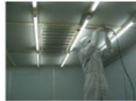
净化室FFU下安装
