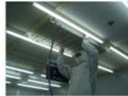
净化室FFU下安装
